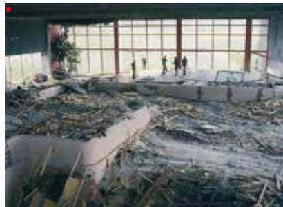
1985 versagte die abgehangene Betondecke eines Hallenbades im schweizerischen Uster. Die Aufhängungen der Decke aus nicht rostendem Stahl zeigten rein äußerlich keinerlei Mängel, waren jedoch innerlich teilweise vollkommen durch Spannungsrisskorrosion zerstört.
